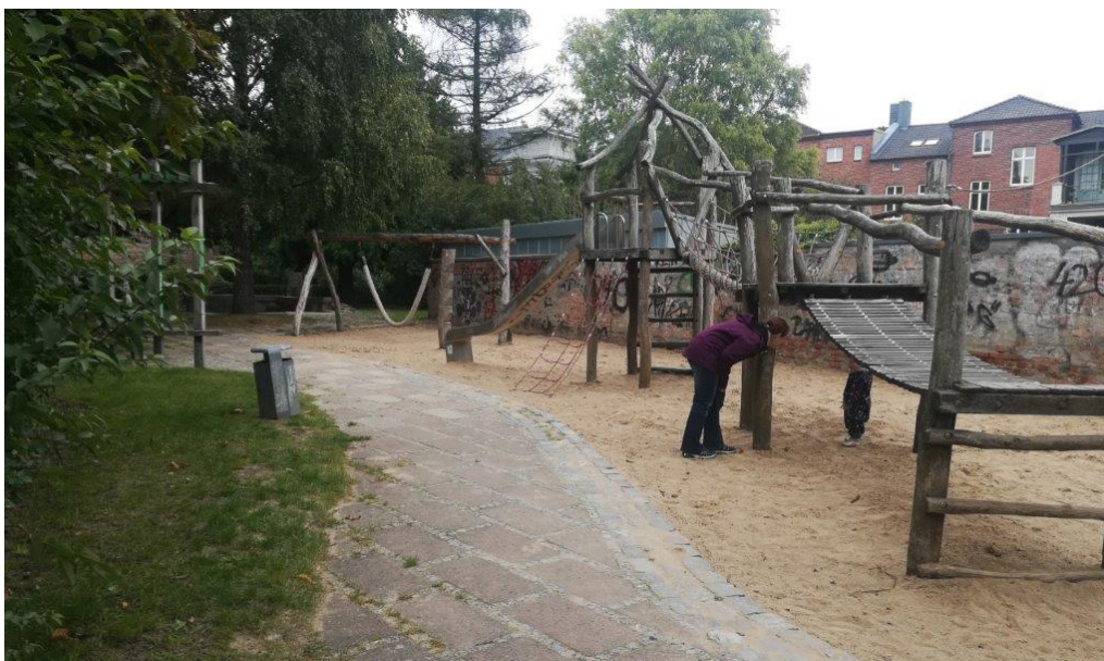
Die Spielgeräte aus Robinienholz werden durch neue ersetzt und bekommen das Aussehen einer Ritterburg und einer Wallanlage
