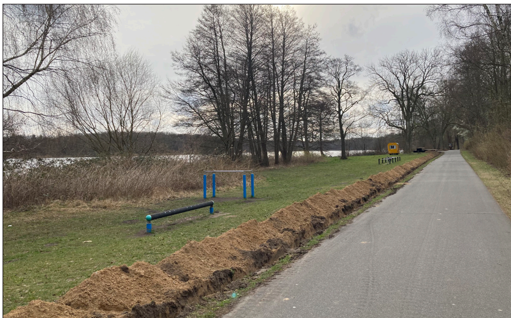
Der Radweg am Faulen See mit dem Kabelgraben für die Leuchten, die am Weg errichtet werden
