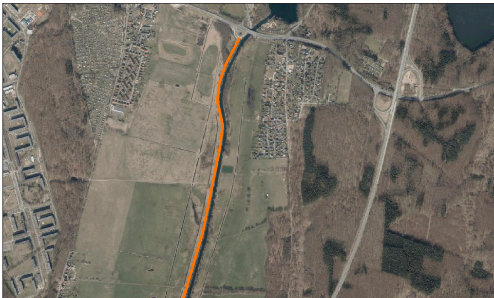
Die Markierungen zeigen den Bauabschnitt des Radweges am Störkanal
