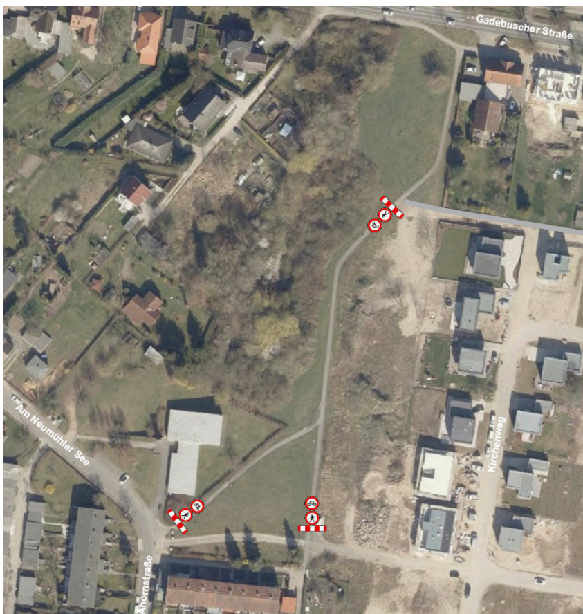
Blick auf den Bereich der Instandsetzungsarbeiten
