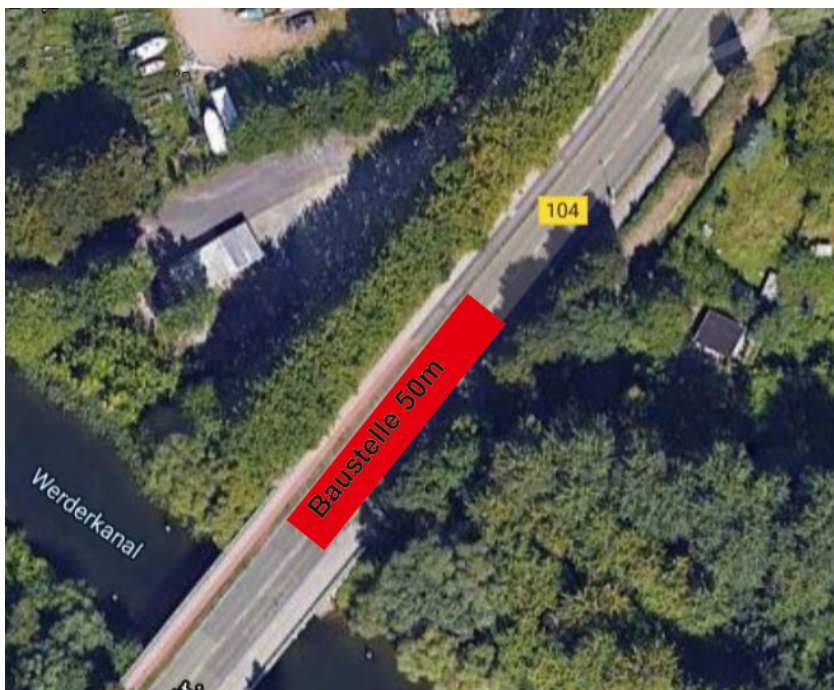
Blick auf den Bereich der Arbeiten in der Güstrower Straße
