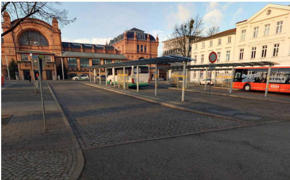
Blick auf die zu reinigenden Unterstände am Grunthalplatz
